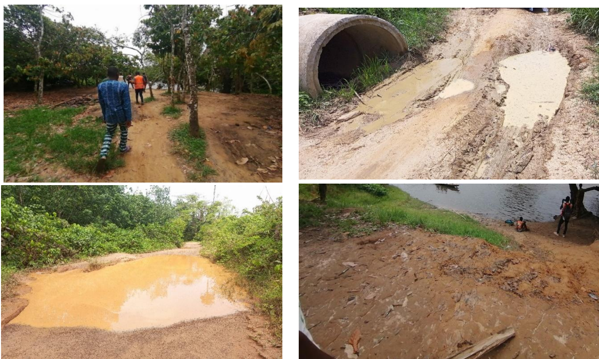
Planche 2: Vue de cas de dégradation de sol
